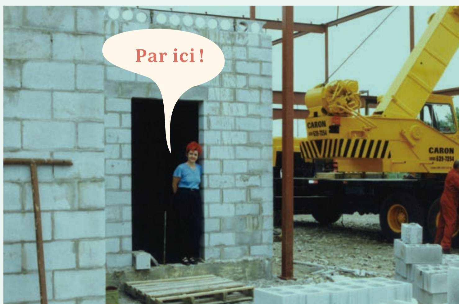
LA VOÛTE LORS DE LA CONSTRUCTION DE L'HÔTEL DE VILLE, 1999
